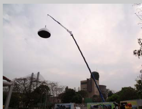
以 110 噸重型吊臂安裝圓頂。
